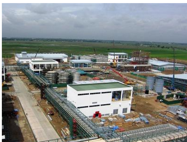
工事中の工場設備
